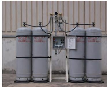
「ISU-4」ユニット本体。容器(50kg×4本)と接続してLPガスを供給。トラック等に積載してどこにでも持ち運びが可能。
